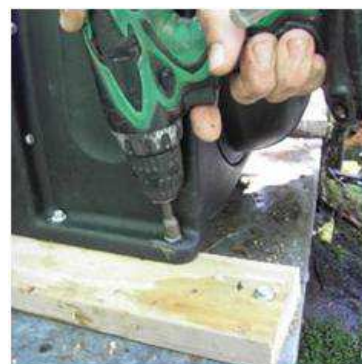
タービンを木製基礎に固定
