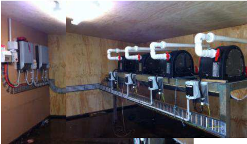
6.4kW(4 台の PLT200 発電電圧 171 VDC が 2 x 4kW インバーターで売電)
