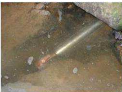
ステンレス管に穴を開けた取水方式
