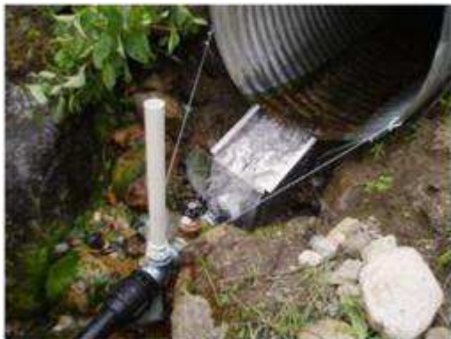
排水出口で取水
