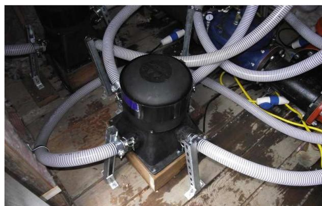
\* 御問合せには、**正確**な落差、流量、御希望電圧をお教え下さい。そのデータにより最適なモデルをお薦めします。価格目安は、TRG 価格に上記の MPPT 価格を追加してください。制御ボックスは別途見積りです。なお落差は別としても**流量が 8 リッター以上なら、ターゴ型**、8 リッター以下ならペルトン (PLT) になります。落差と流量により、ノズル開口量とノズル数が変化します。実際の状況で応用願います。
