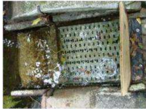
開口付メッキ済み電線用管を利用
