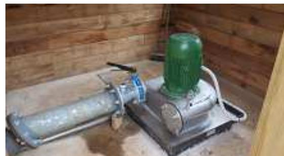
自己励磁発電機 6kW で系統連系。パワーコンディショナーは、風力用が承認されているそうです。
