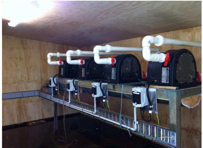
ローター(回転体)に永久磁石を使った発電機を、風力用パワーコンディショナー経由で系統連系しています。発電機は1台 1.5kW でも4台並列で6kW 発電しています。
