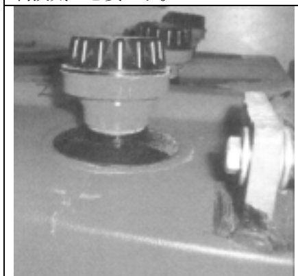
図 9-12:特殊なキャップを各セルに取り付け充電時発生する水素酸素ガスを水に戻す事が可能です。
