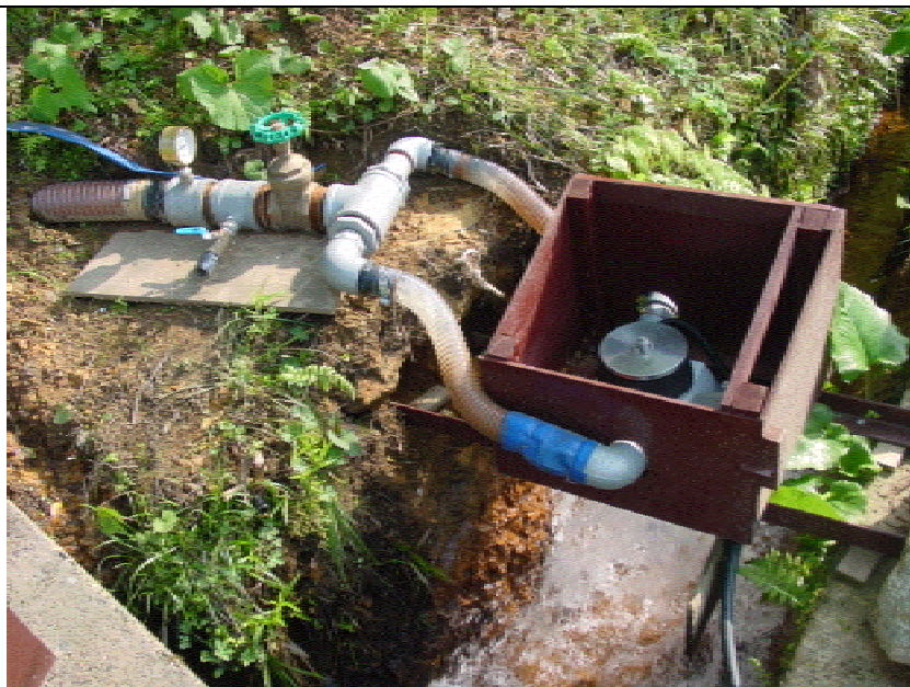
N 邸水力発電装置：写真提供 福井市 西村様
