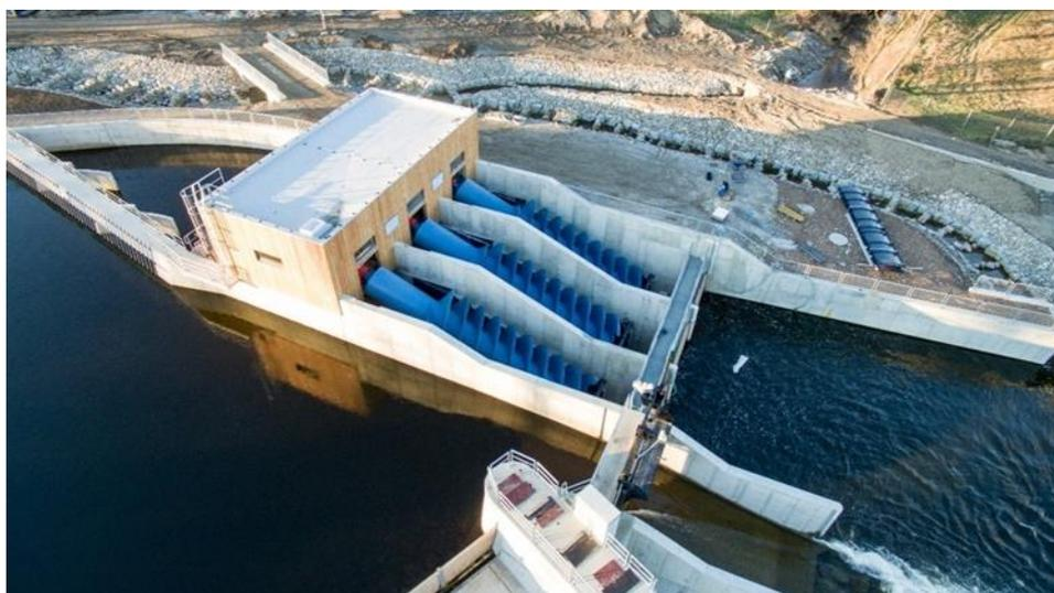
河川の為、落差は 3.5m-2.3 と変化し、流量も 4.5ton から 27トンと変化。この環境変化に対応可能なのが唯一螺旋で有る事を知る人は少ないと思う。3 台x200kW の螺旋を設置し、1 台当たり 8.7 トンを受け持ち、年間総発電量 2,138 メガワットを実現。総工事費の完全償却には 8.4 年が必要だが、他の発電方式ではこの発電量や償却が見込めない。この例は無から有に変えられた現実だが、ここに至るまでに、話を 1980 年代に戻らなければならない。
