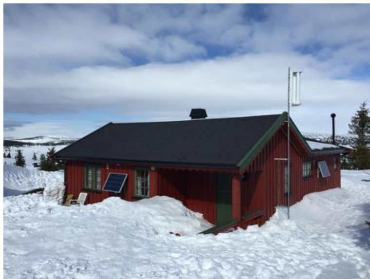
静音なので家の屋根に設置可能
